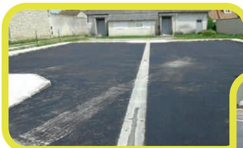
A la suite des malfaçons constatées, réfection totale du parking avec pose d'un caniveau central pour un meilleur écoulement des eaux pluviales.
